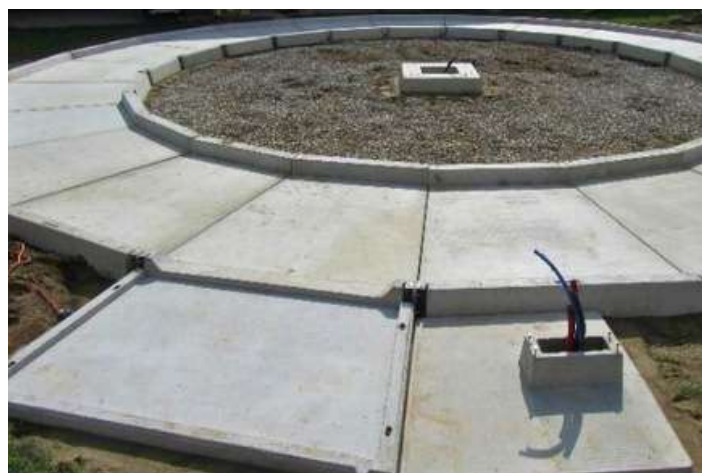
Base de marcheur béton armé préfabriqué
