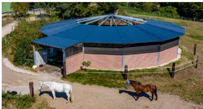
Marcheur couvert panneaux béton armé 10 cm
