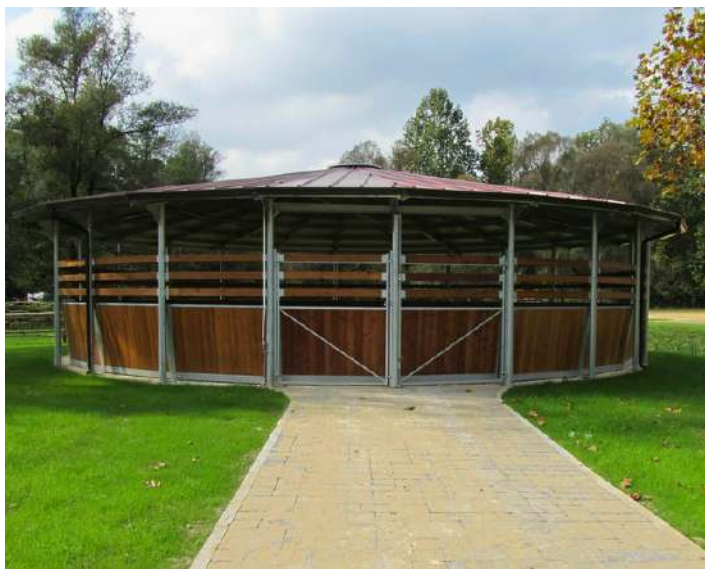
Rond de longe avec toiture isolée
