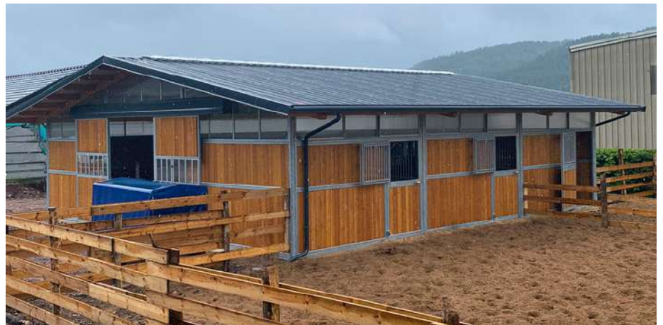
Bardage en béton armé effet bois
