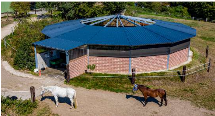
Marcheur couvert panneaux béton armé 10 cm
