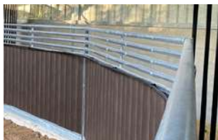
Clôture résine avec réhausse tubes
