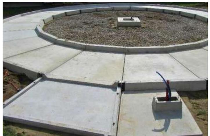
Base de marcheur béton armé préfabriqué
