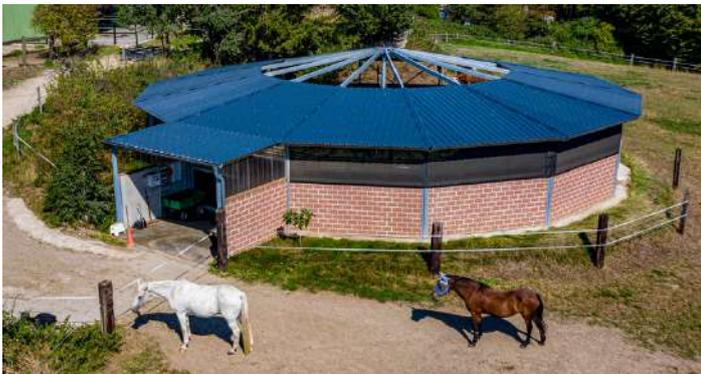
Marcheur couvert panneaux béton armé 10 cm
