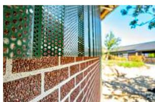
Tôle trapézoïdale perforée
